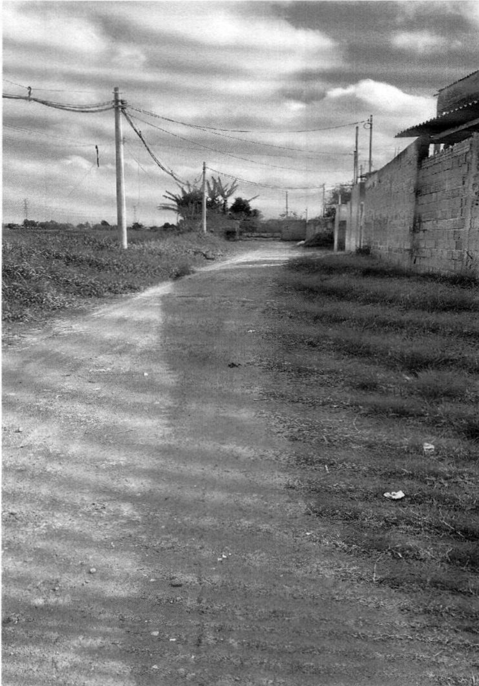
IMPLANTAÇÃO DE GUIA E SARJETA EM TODA A EXTENSÃO DA ALAMEDA JUNDIAÍ, JARDIM SANTOS DUMOND II- MOGI DAS CRUZES.
